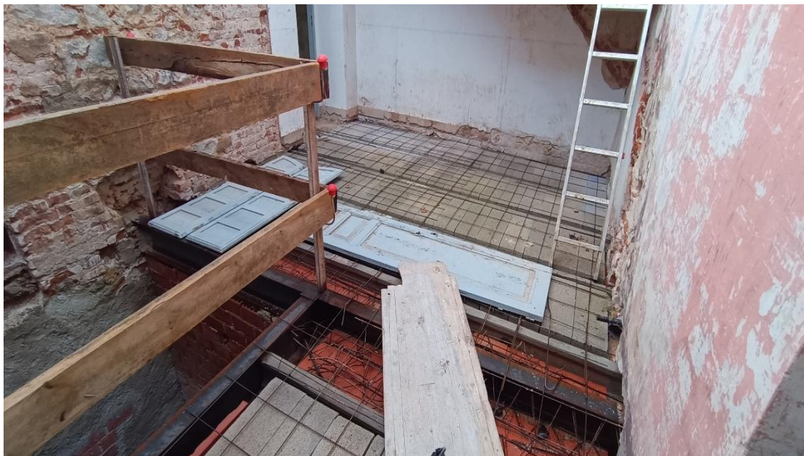
OBRA CENTRO DE INTERPRETACIÓN DEL ALMENDRO
