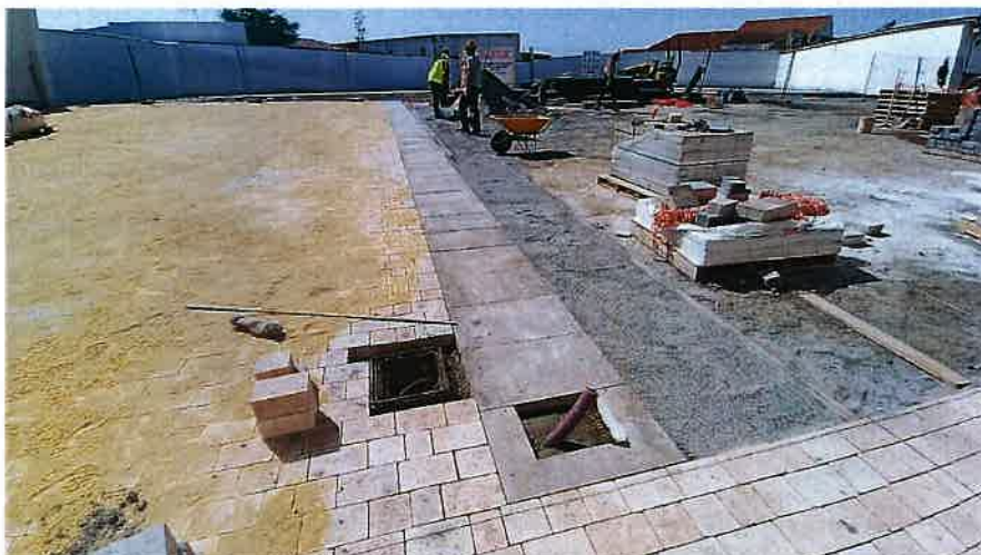
OBRA SEMIPEATONALIZACION CALLE TESORO
