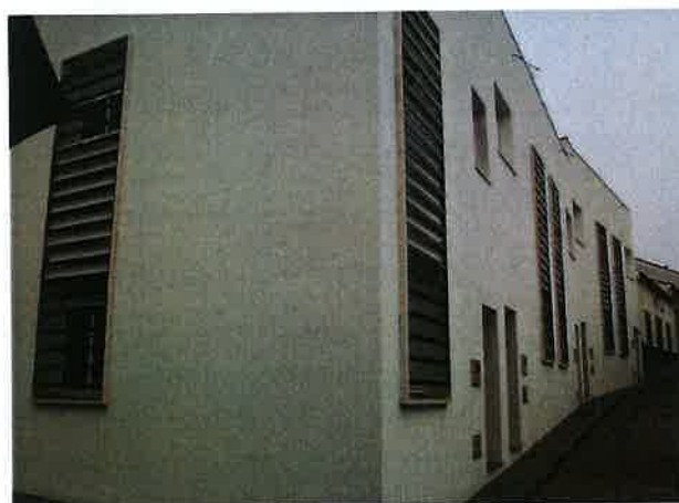
VIVIENDAS VPO C/ADUANA Nº 44
